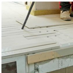
Holzständer an Fassade und aufgebrachte Holzfaserplatten. Der Zwischenraum wird mit Zelluloseflocken ausgeblasen.
